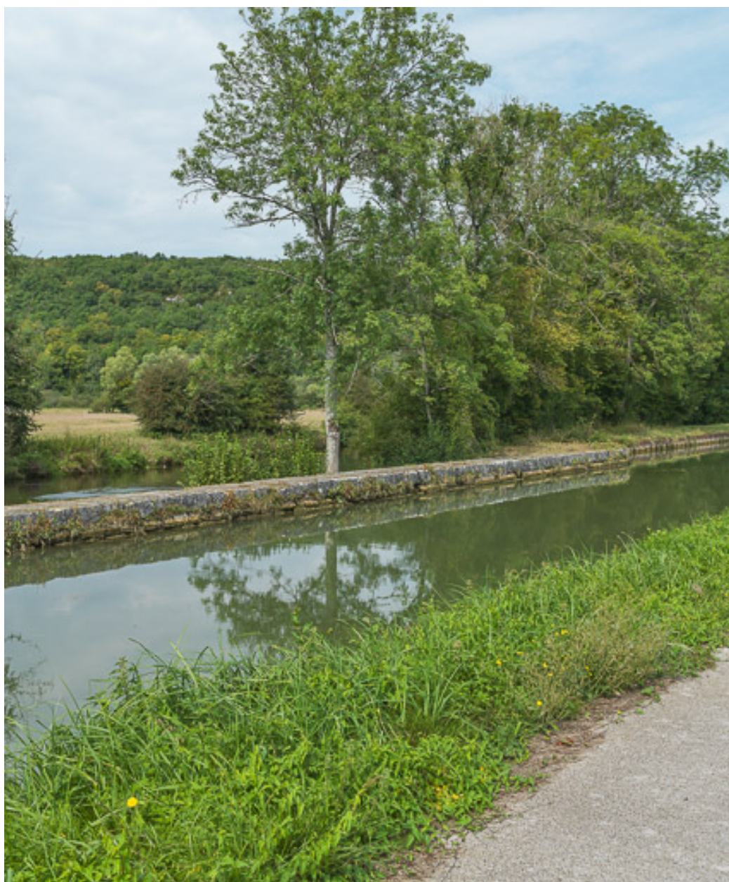
Détail de la digue.
