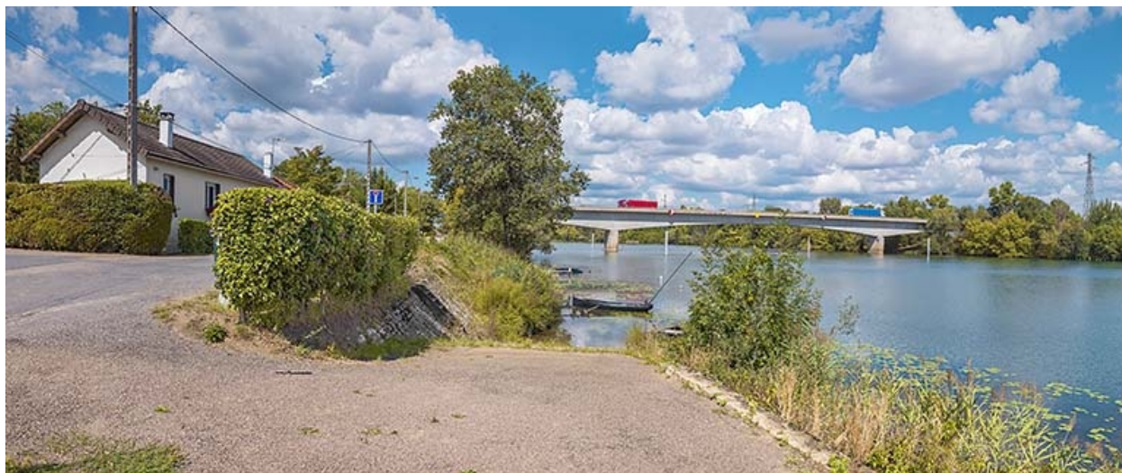
Rampe et perré du port.
