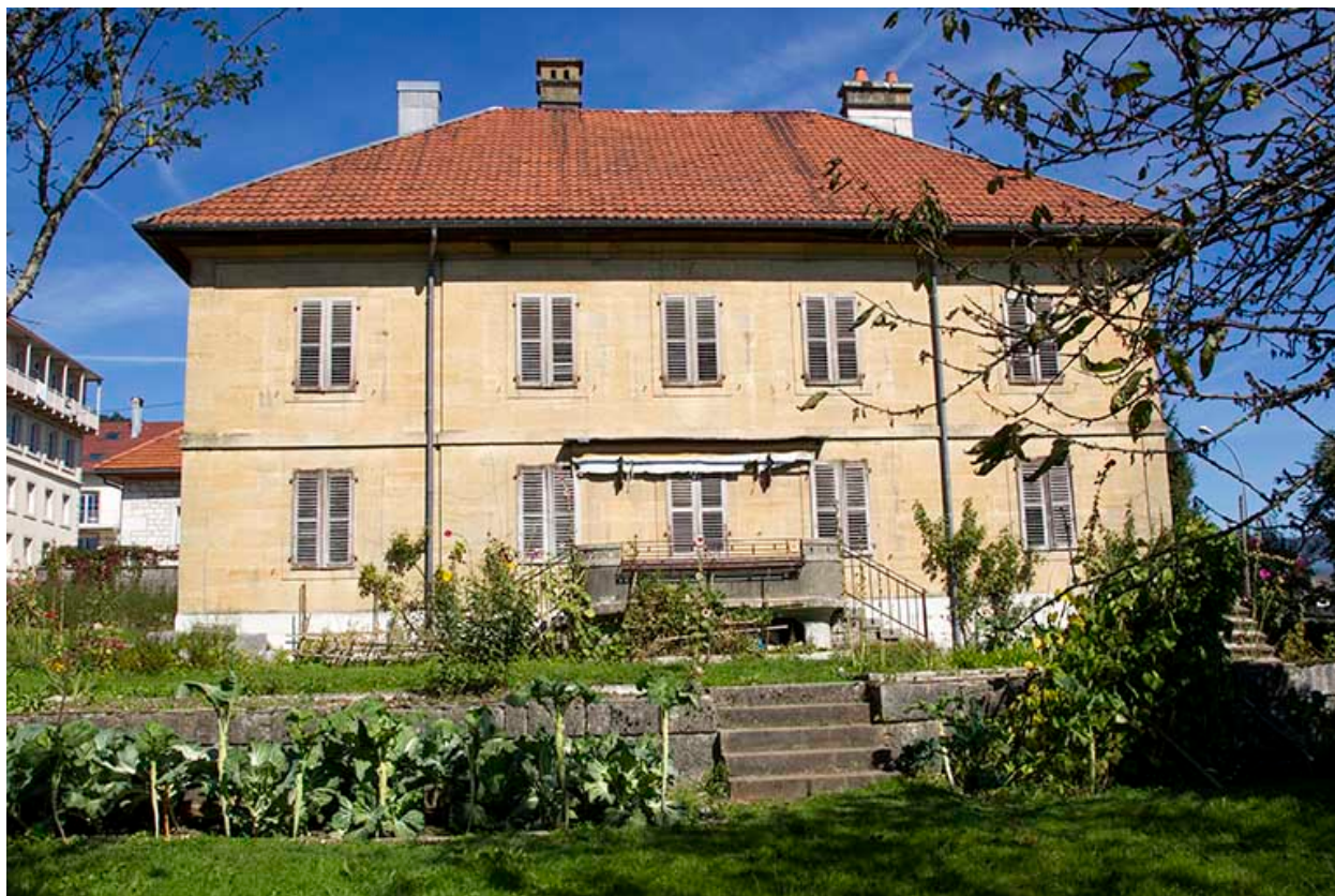
Corps sud : façade latérale droite.
