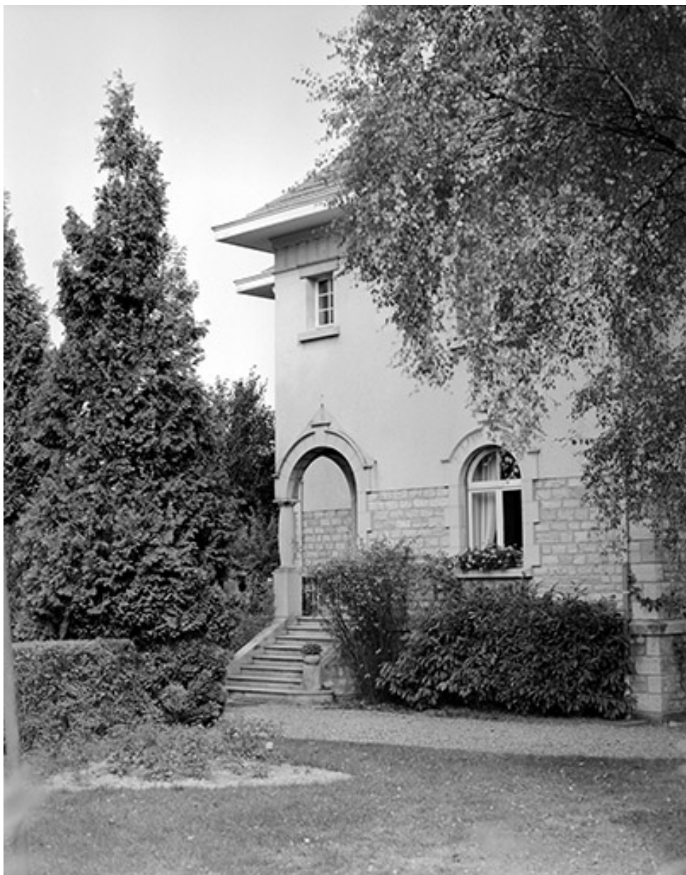
Détail de la face gauche.
