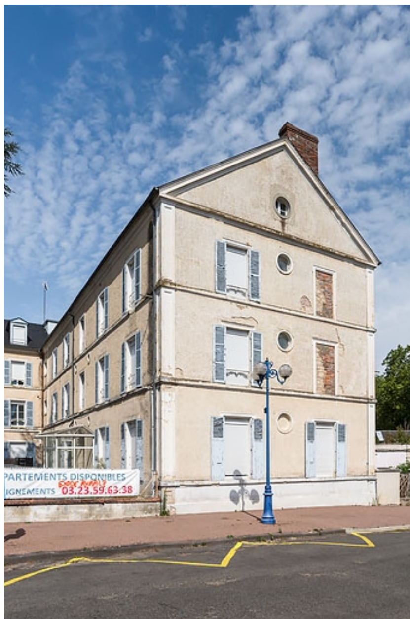
Façade est du corps principal, vue en 2020.
