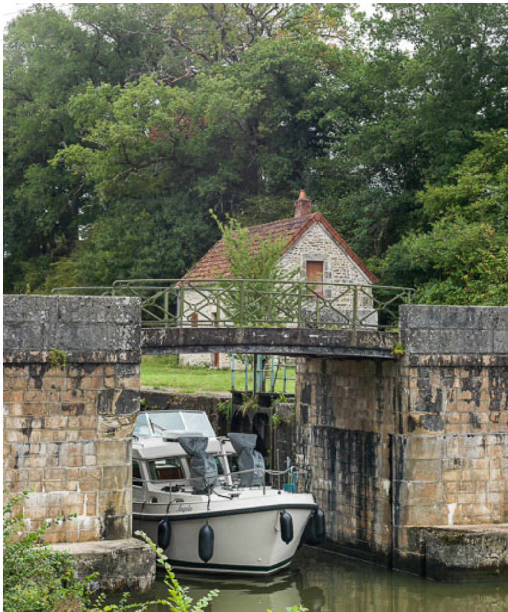
Vue du pont.
