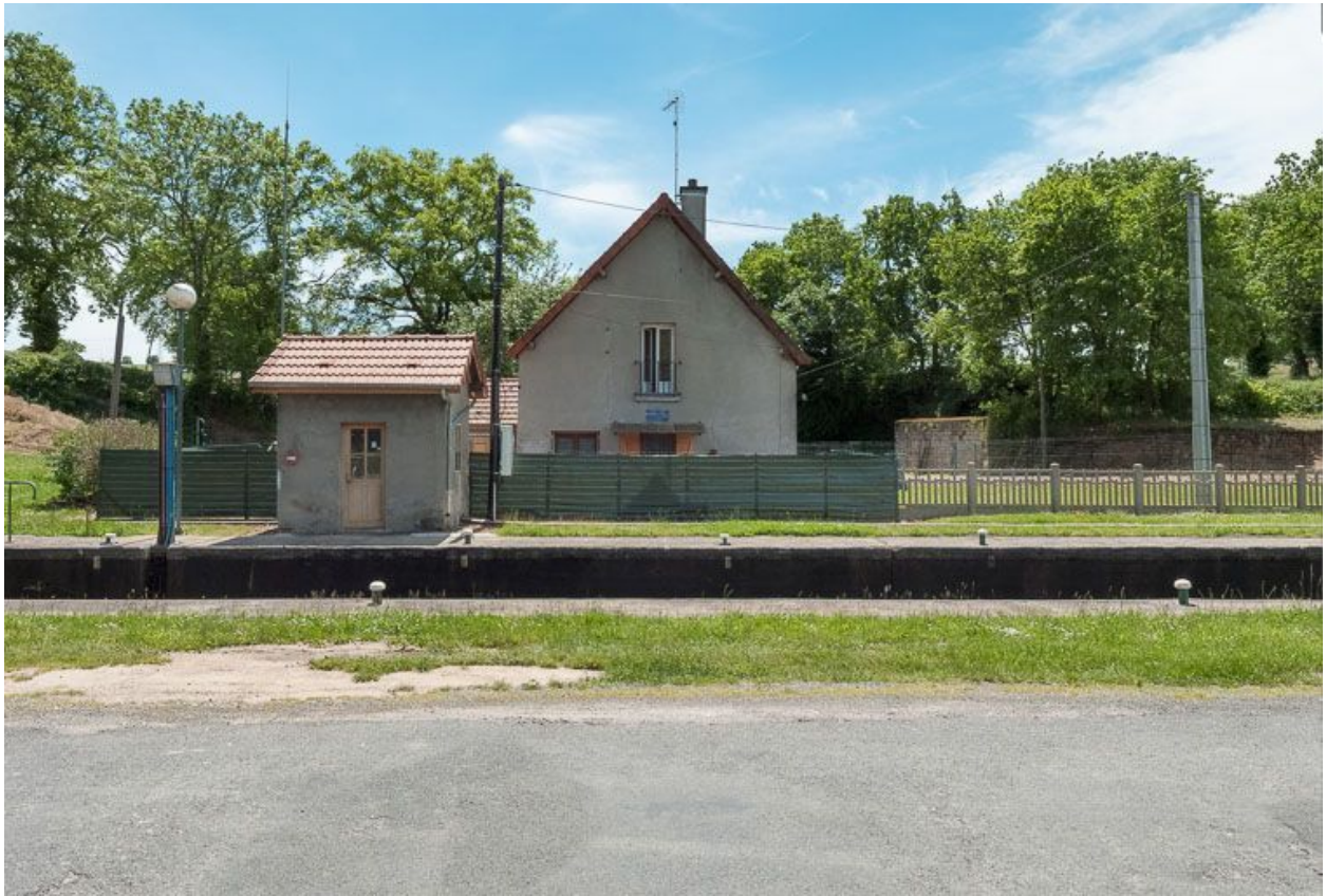
Vue de face de la maison éclusière.
