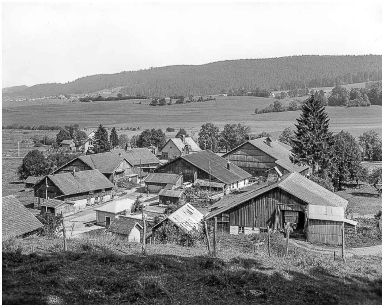
Hameau des Cordiers : façades postérieures des fermes.
