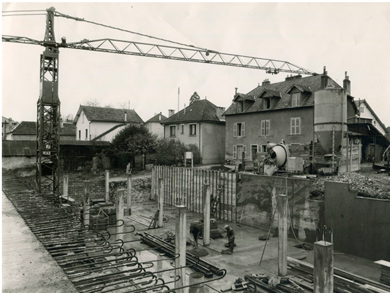
Chantier de construction de l'usine B, fotogr., 1961.
