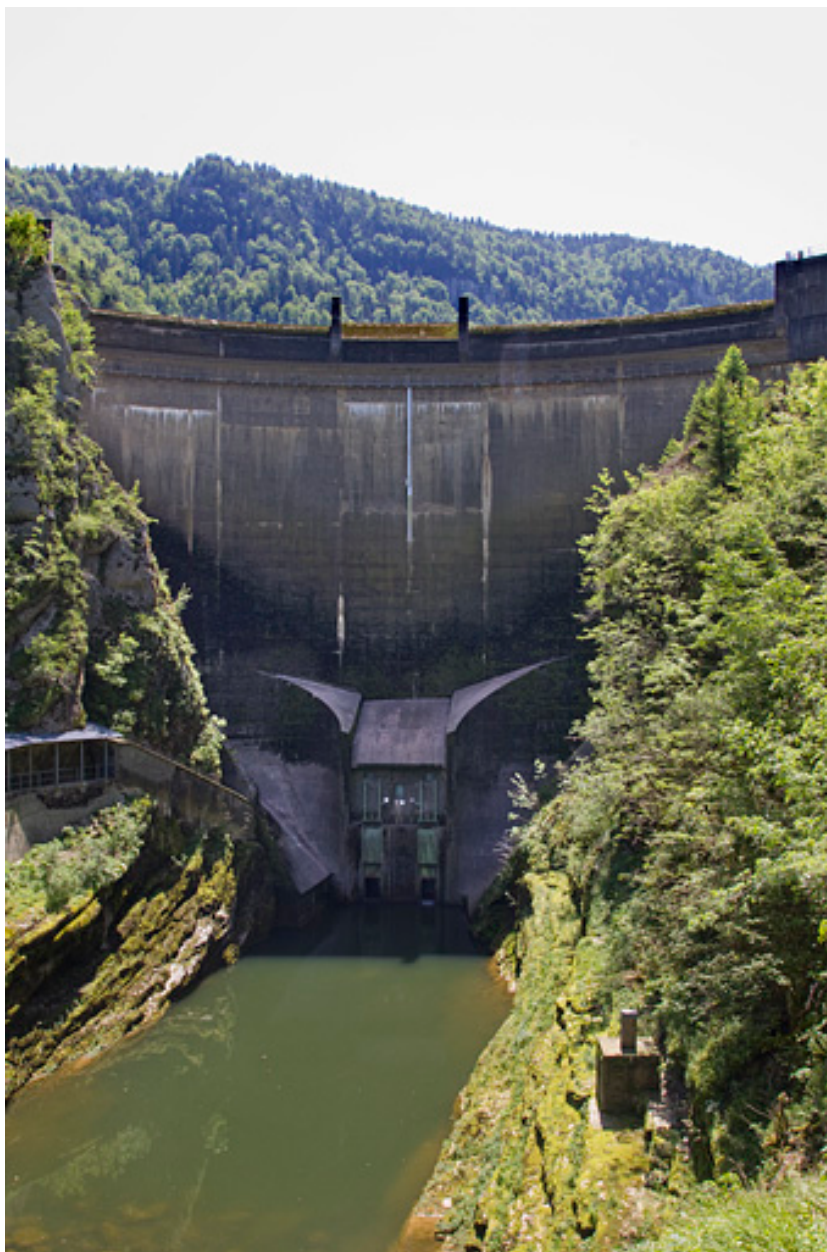
Barrage du Châtelot : face aval.
