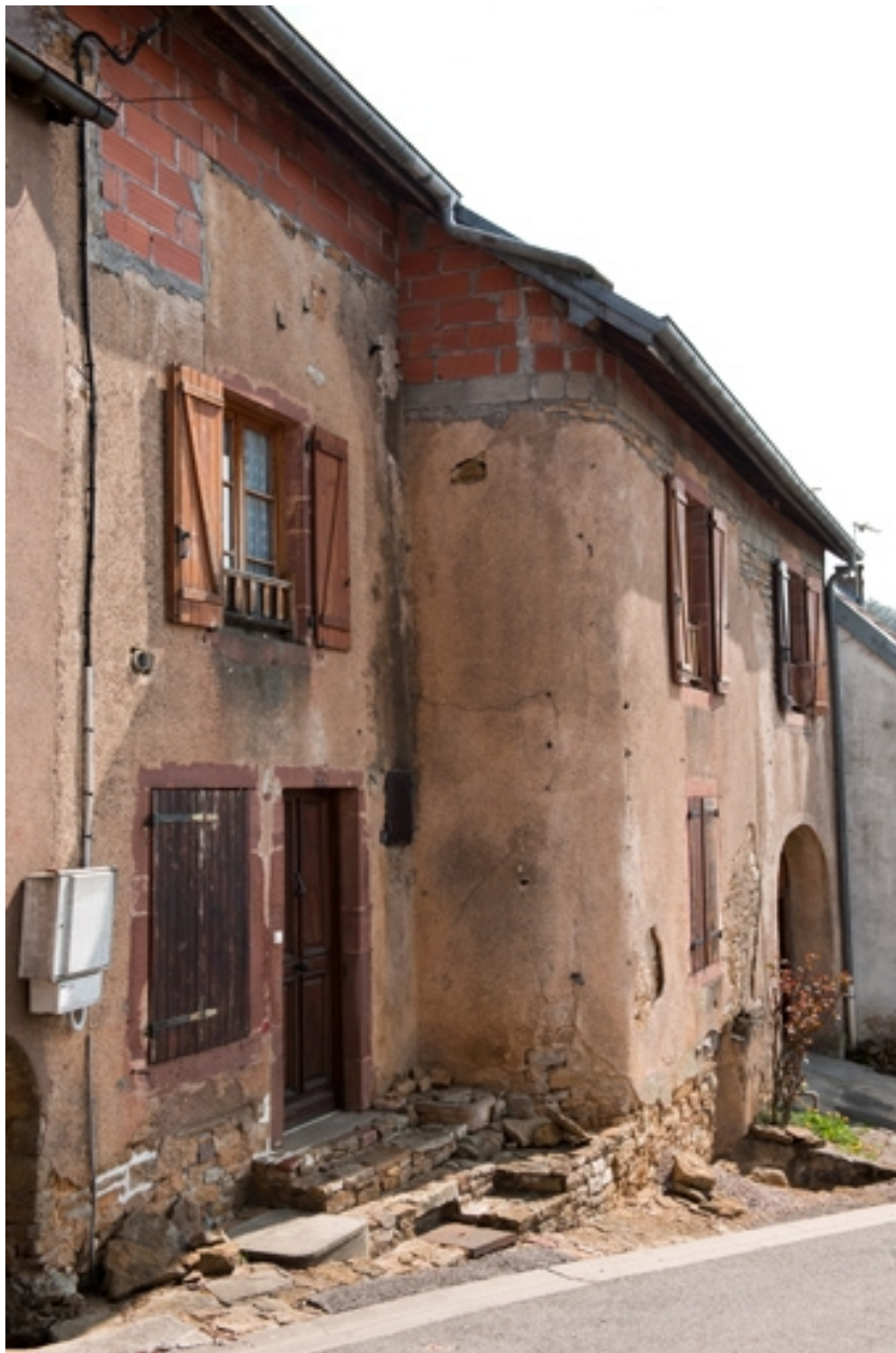
Façade antérieure, vue de trois quart gauche.
