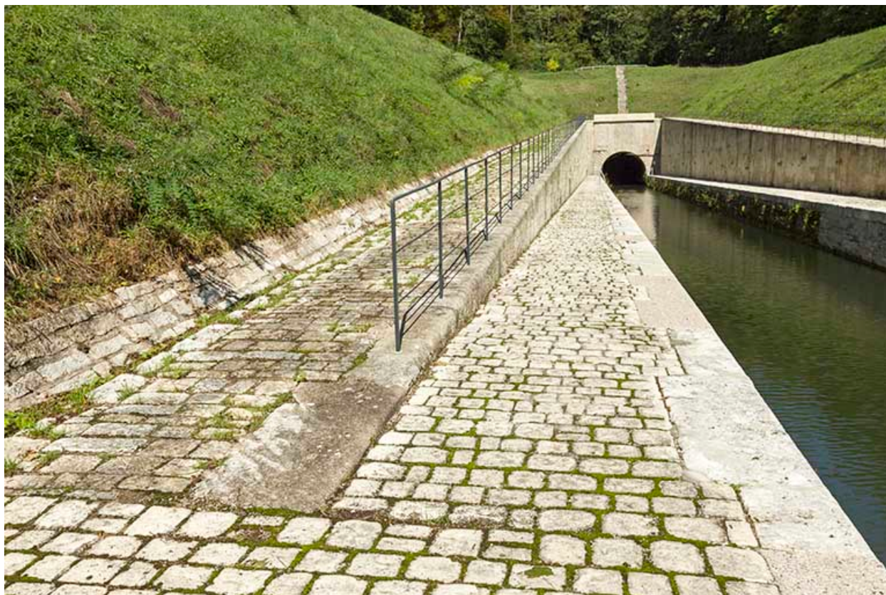
Pavage du chemin de halage.
