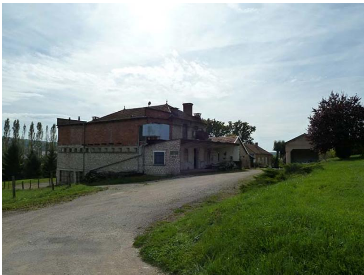
Vue générale nord-est
