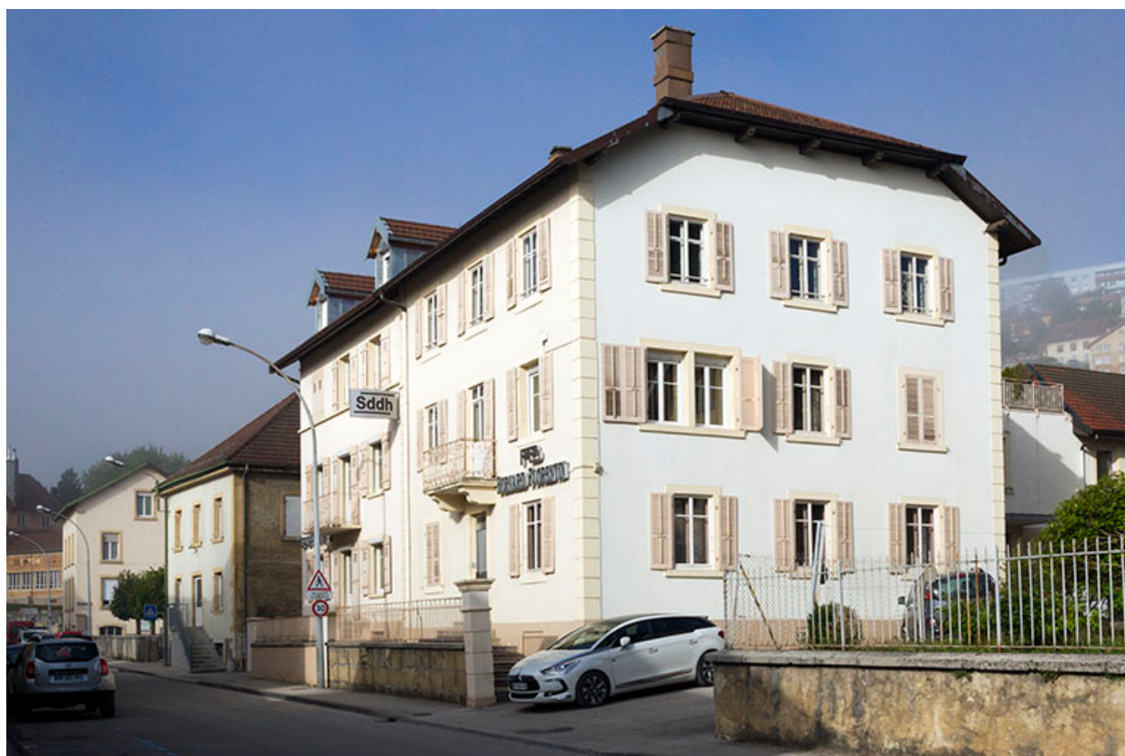
Façades antérieure et latérale droite.
