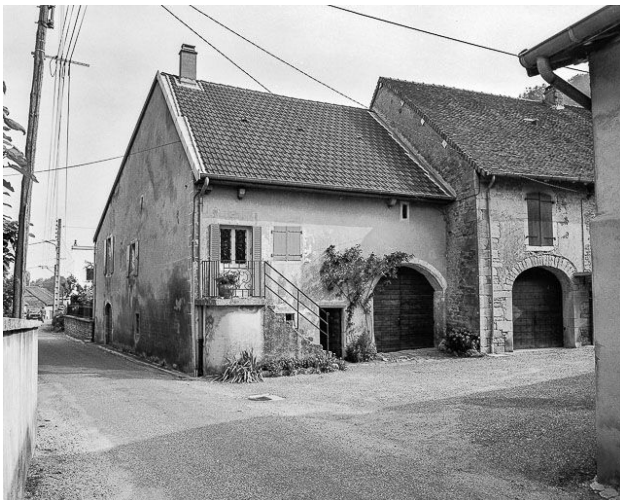
Maison du maréchal-ferrant située rue de l'Huilerie.
