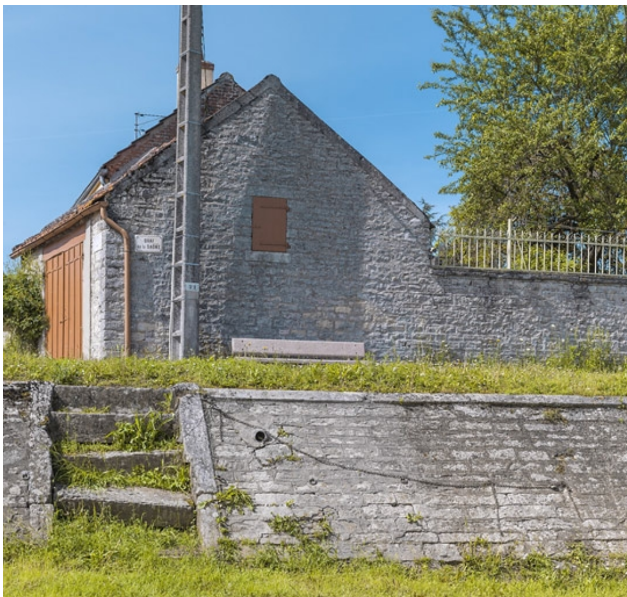
Escalier de sauvetage.
