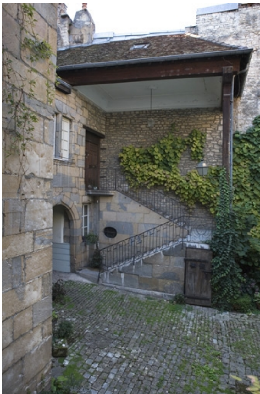
Vue d'ensemble de l'escalier extérieur, de face.
