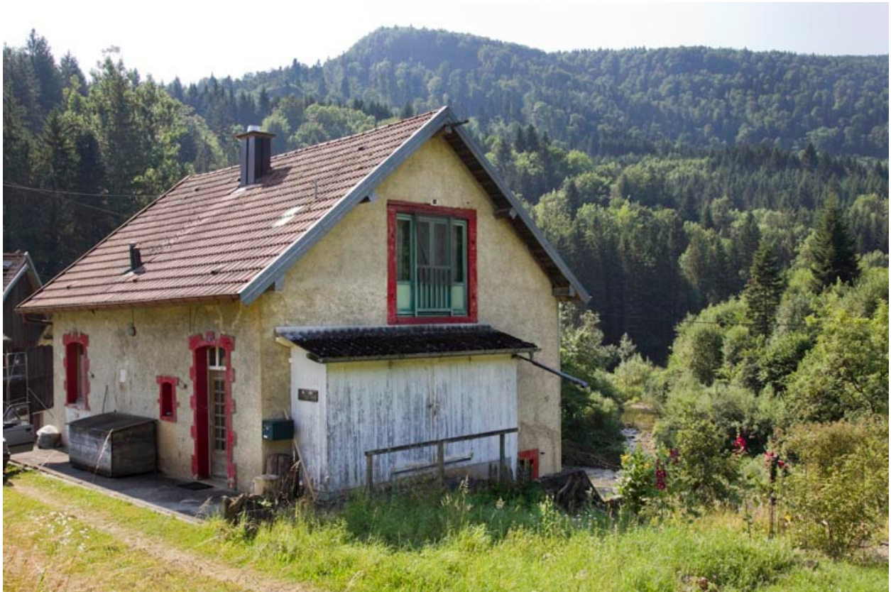
Logement d'ouvriers, de trois quarts droite.
