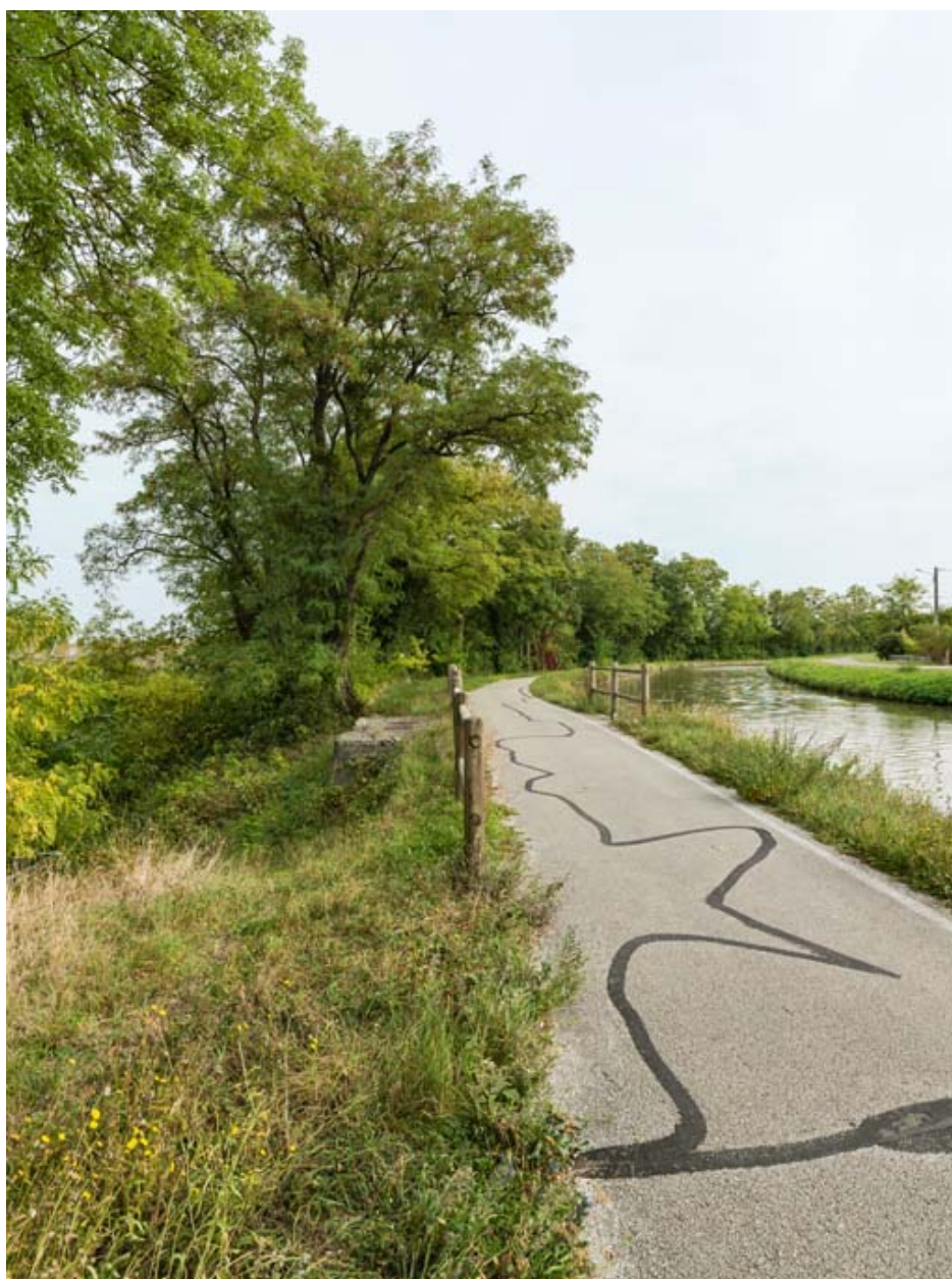
Vue de l'ouvrage.
