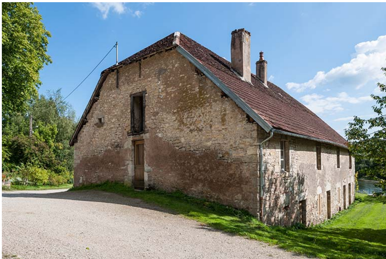
Logement d'ouvriers vu de trois quarts arrière.
