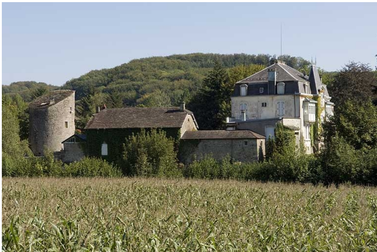
Logement patronal depuis le nord-ouest.
