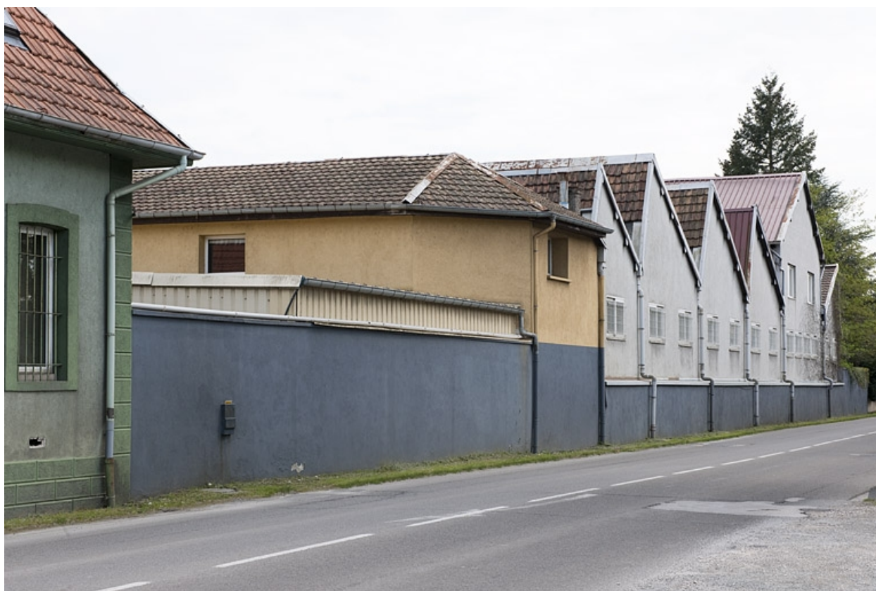
Façade sur rue de l'atelier de fabrication.
