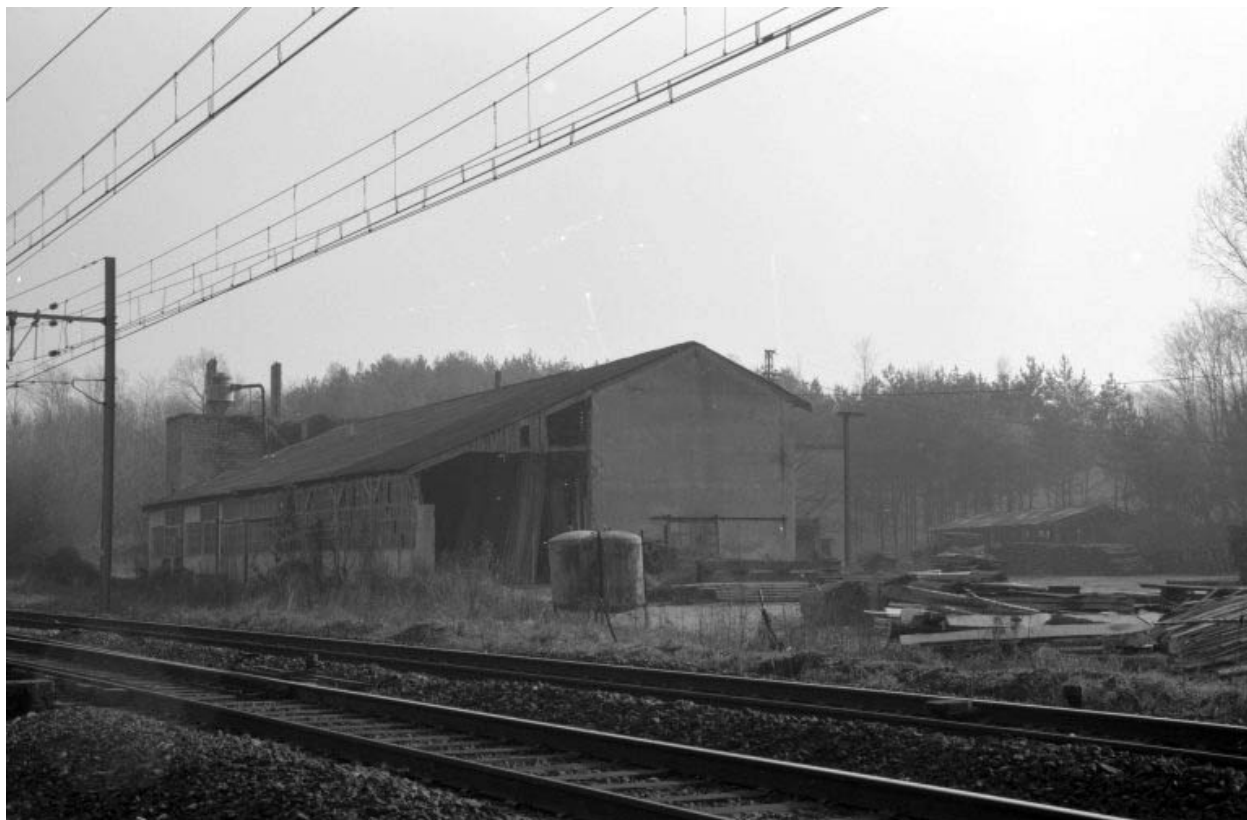
Menuiserie (M), depuis le nord-est.
