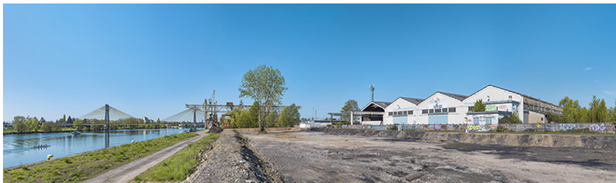
Quai et entrepôts industriels de "Chalon Armatures".
