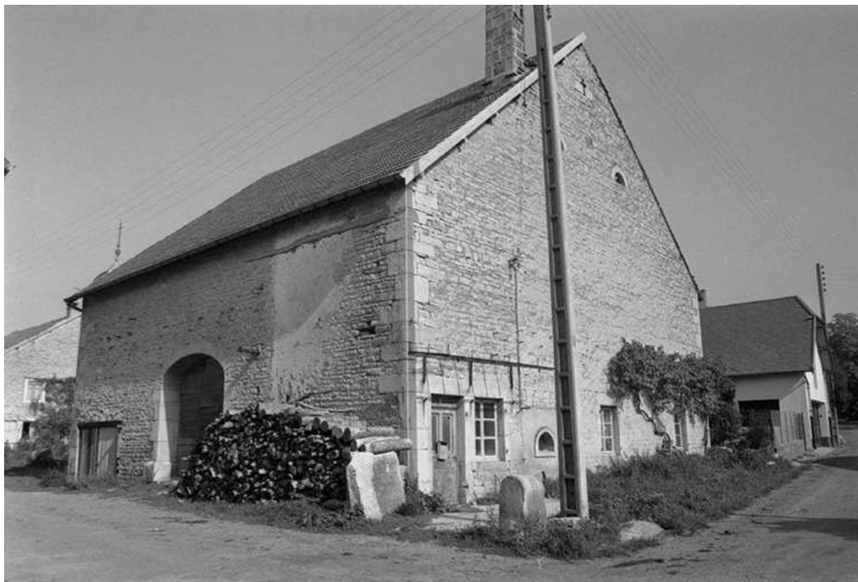
Ferme située 7 rue de Tarcenay.
