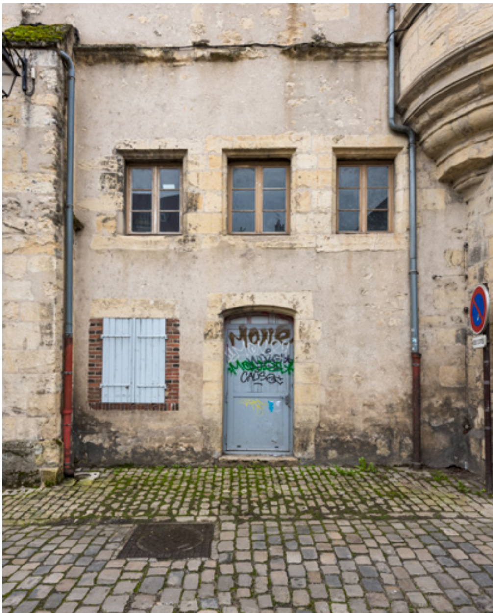
Façade postérieure : partie gauche.
