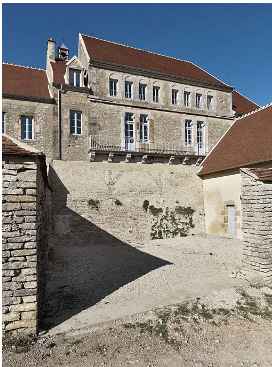
Façade postérieure du corps de bâtiment principal.
