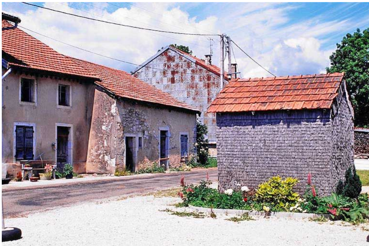
Ferme située au lieudit Orcières.
