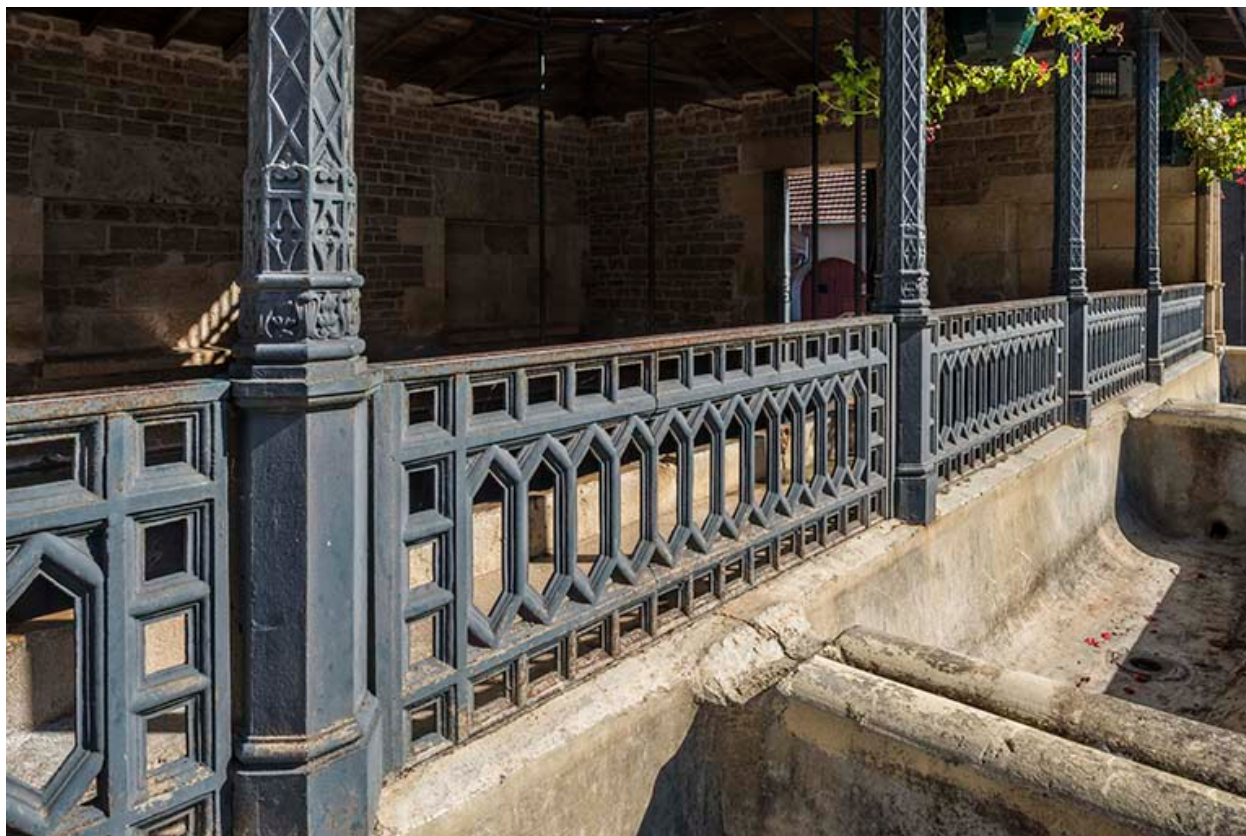
Le garde-corps en fonte.
