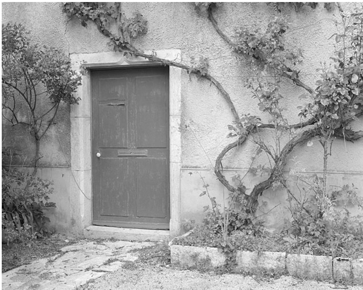
Façade antérieure, détail d'une porte.
