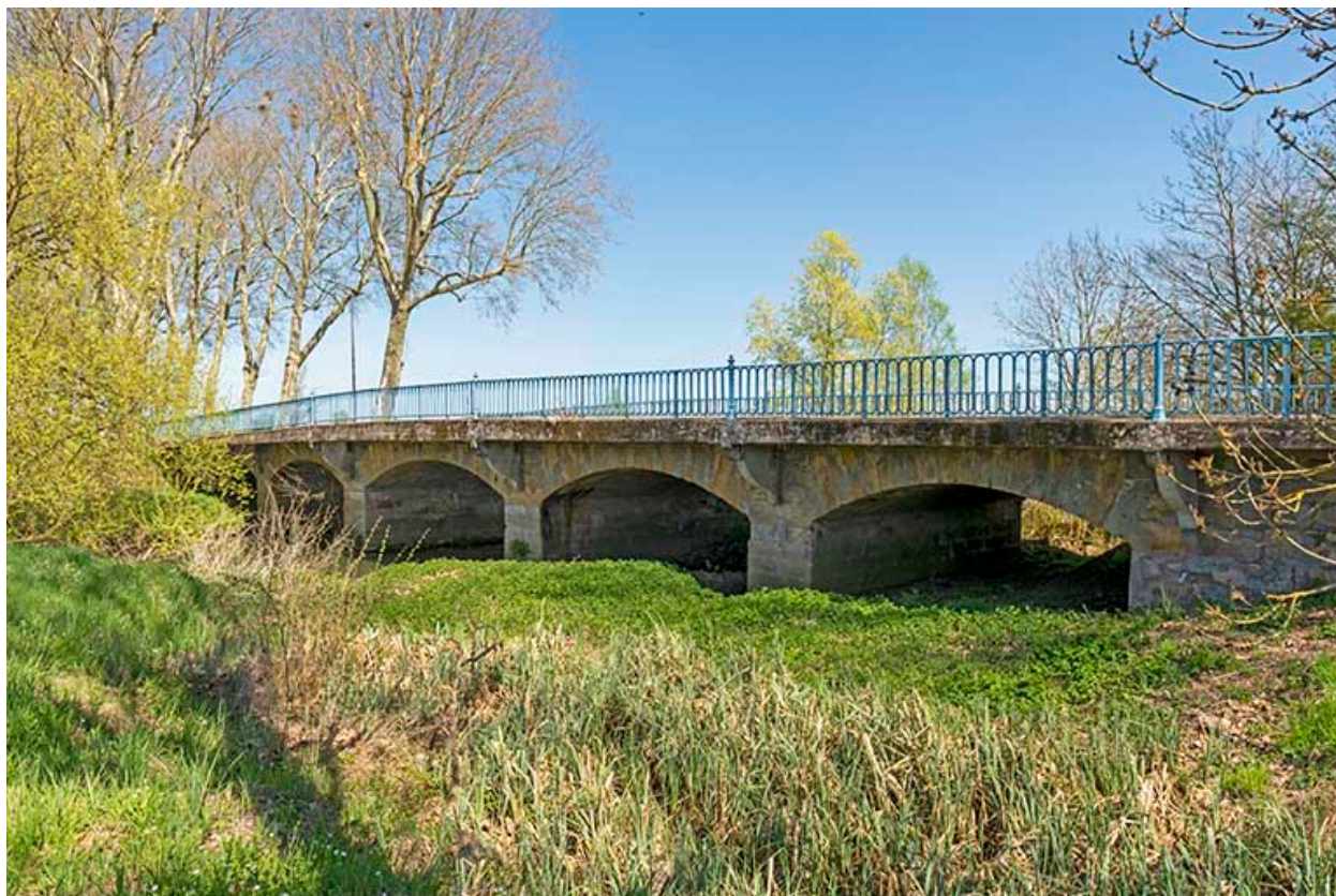
L'ensemble du pont, vu de l'ouest.
