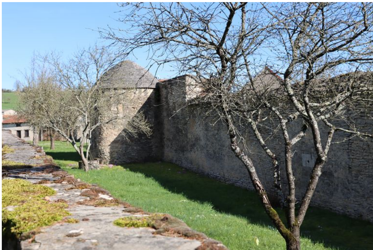
Vue de la tour et du mur d'enceinte depuis le nord-ouest.
