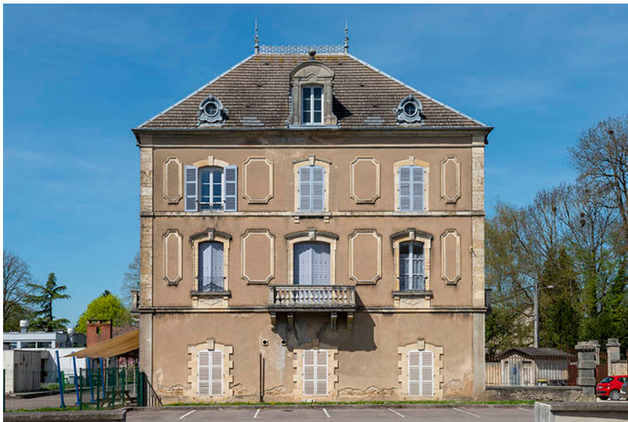
Corps de bâtiment sud, vue de face.
