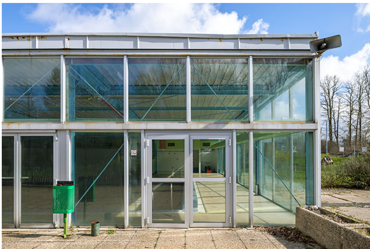
La façade sud-ouest, l'entrée du bassin.
