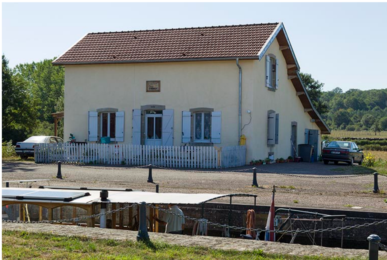
La maison d'éclusier à Ormoy (70).
