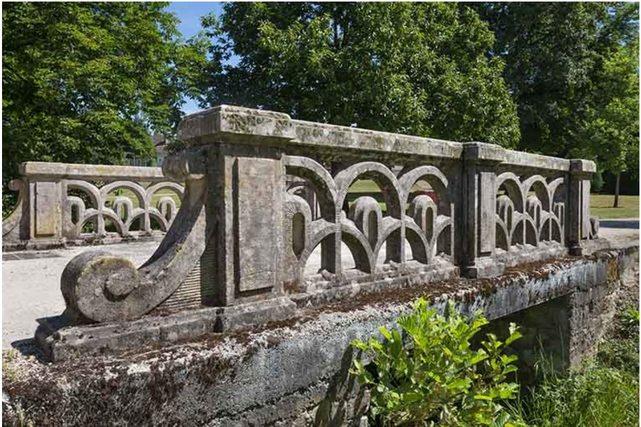
Pont à garde-corps en pierre.
