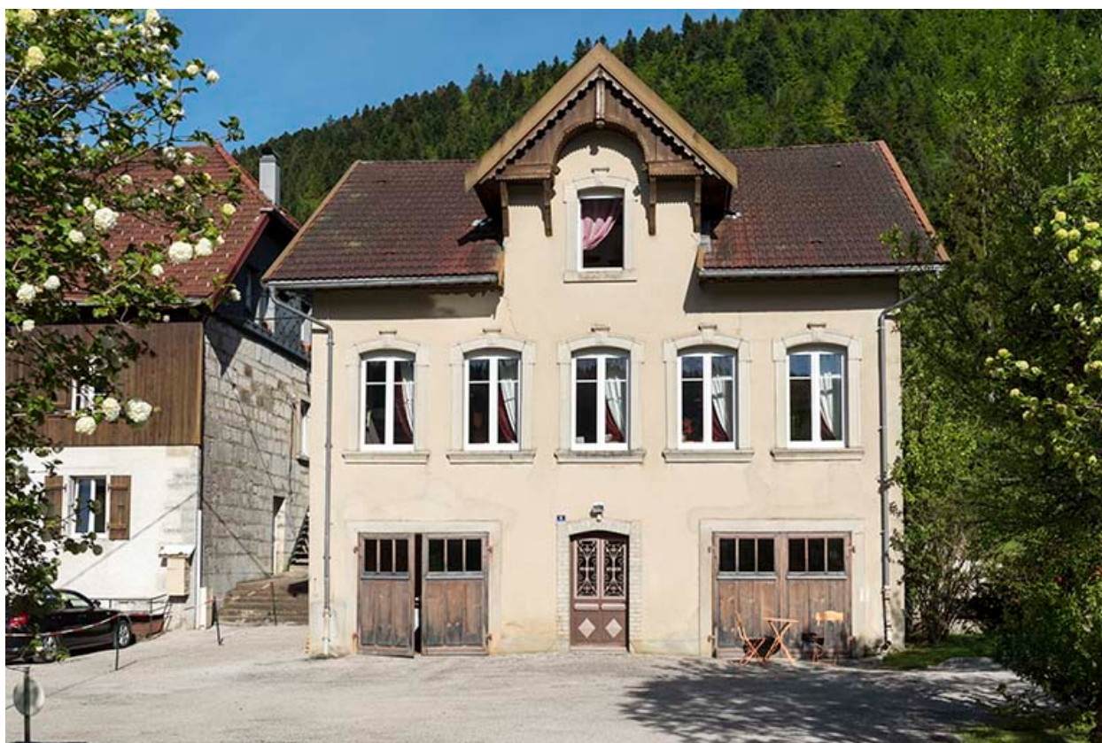
Les Saules : usine de chaudronnerie Bobillier puis atelier d'outillage des frères Baron puis d'Ernest Voynnet (début 20e siècle), 8-10 les Saules.
