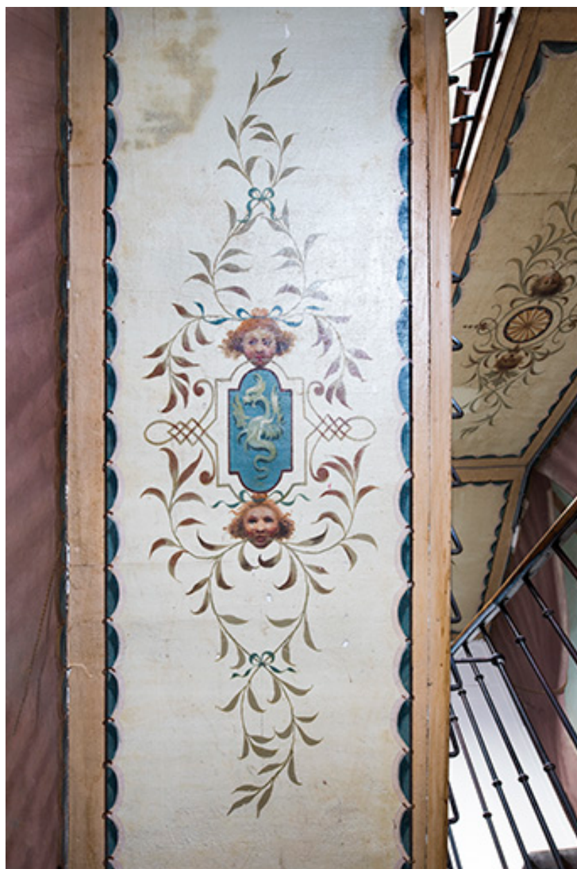
Plafond de la 4e volée.
