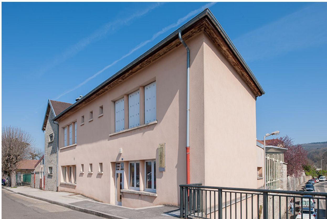
Annexe : façade antérieure, rue des écoles.
