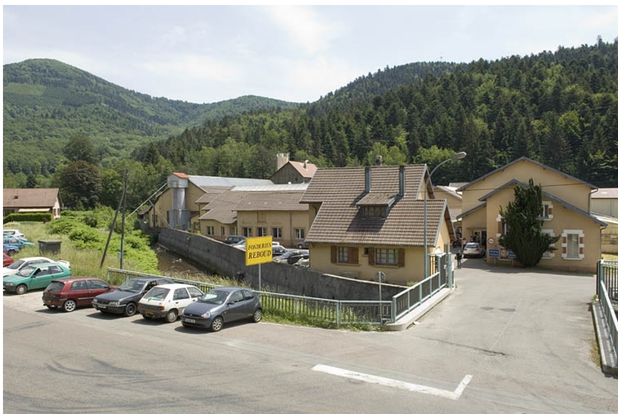
Partie nord de l'usine depuis l'entrée.
