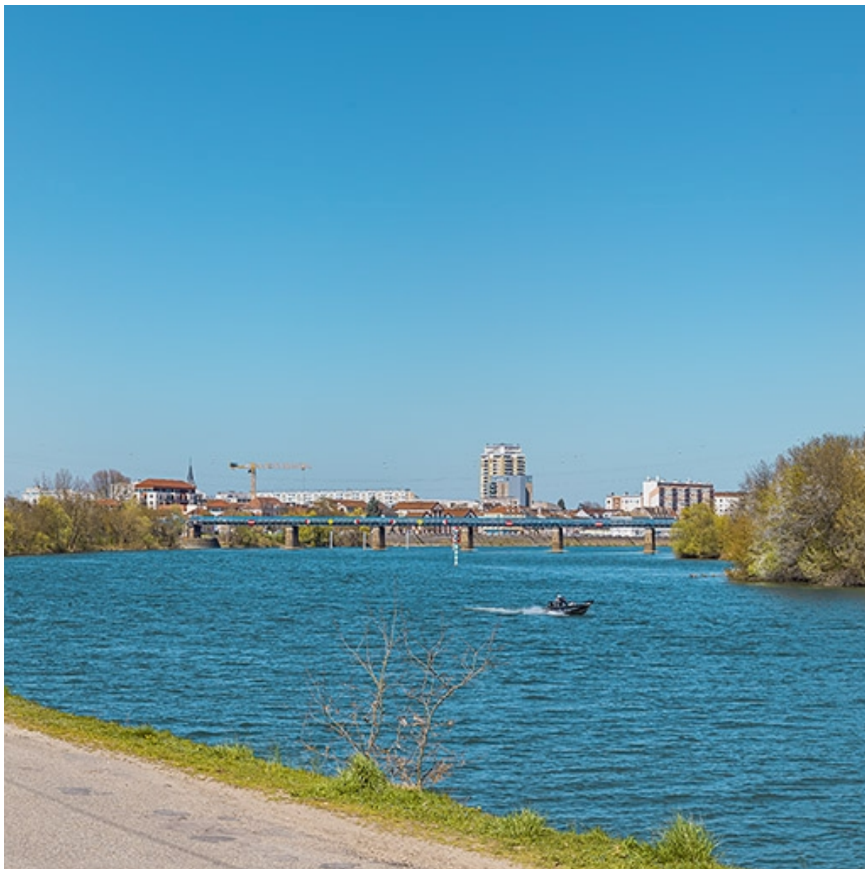
Vue d'ensemble du pont, depuis l'aval.
