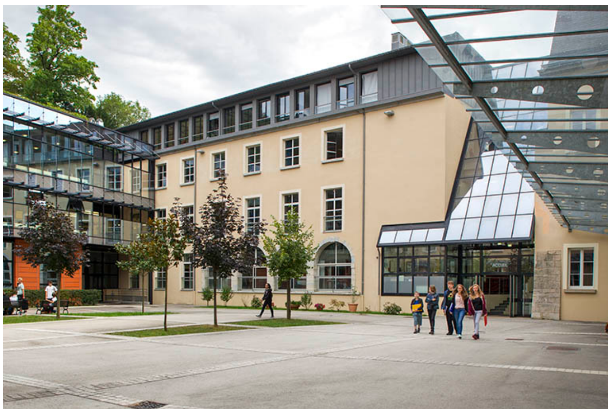
Aile Sud : détail.
