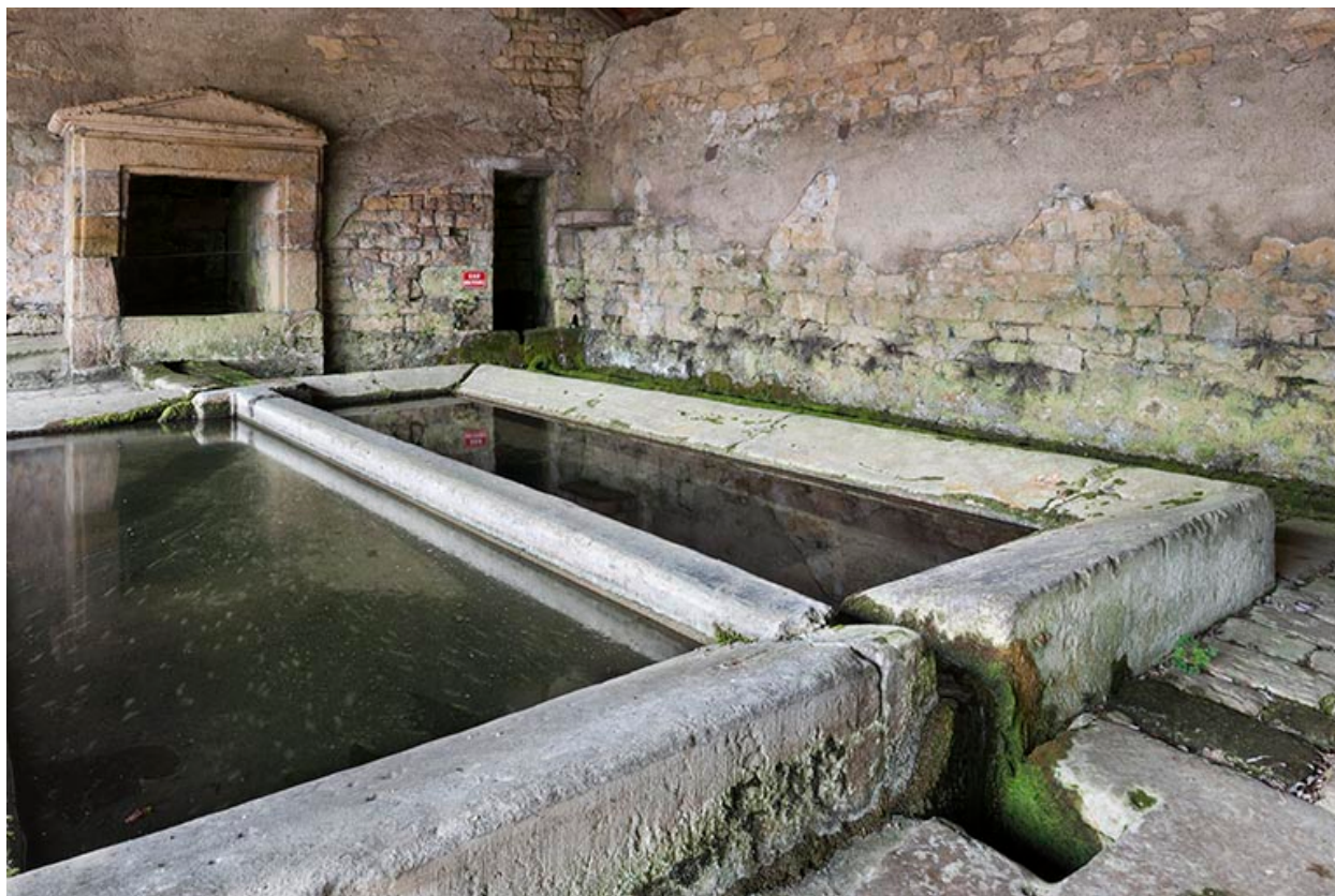
Détail des bassins.
