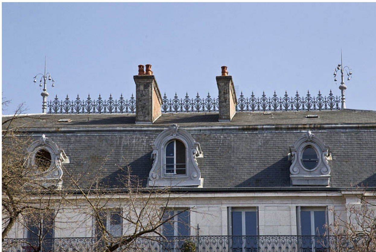
Détail de la toiture en ardoise.
