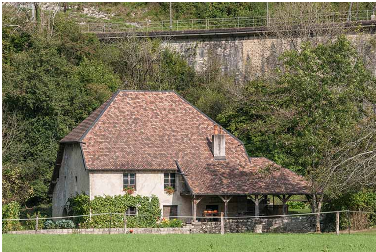
Le moulin depuis le sud-est.
