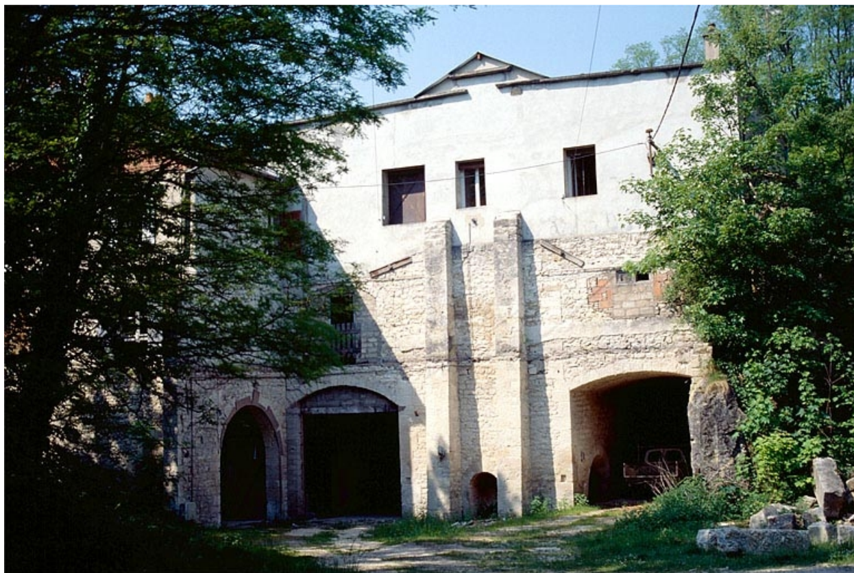
Base du four à chaux, depuis l'est.
