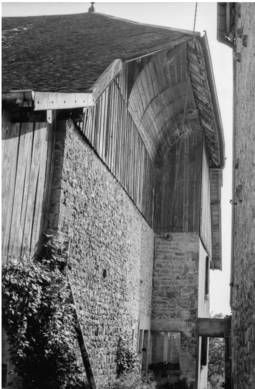
Ferme cadastrée 1961 AB 50 : façade postérieure (?).
