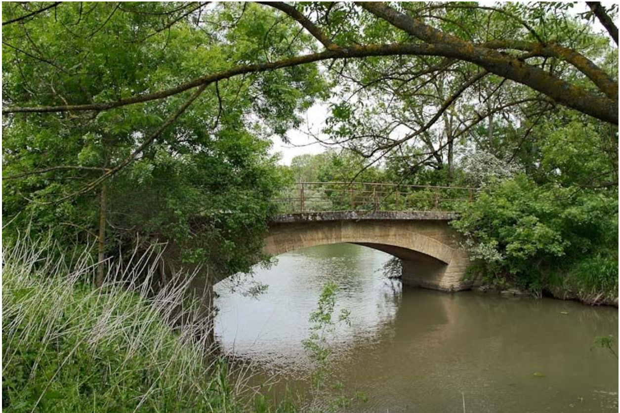
Vue d'ensemble du pont.
