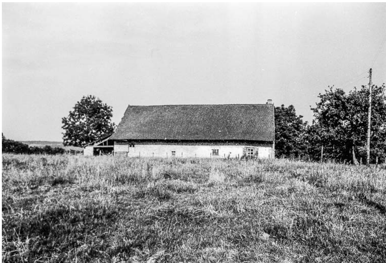
Ferme cadastrée 1969 AD 192 : vue d'ensemble.
