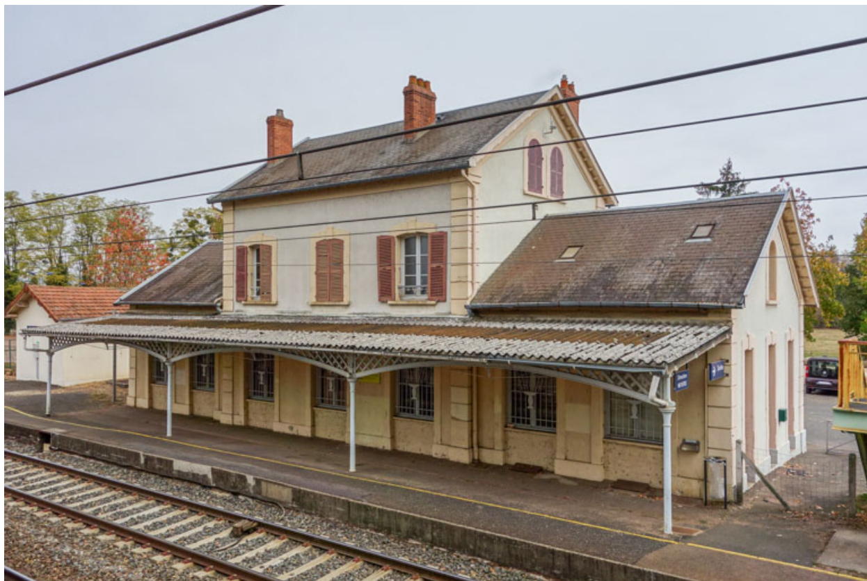
Façade, côté voie ferrée.
